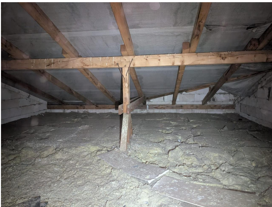
Obrázek 19 Místa poškozená folie
