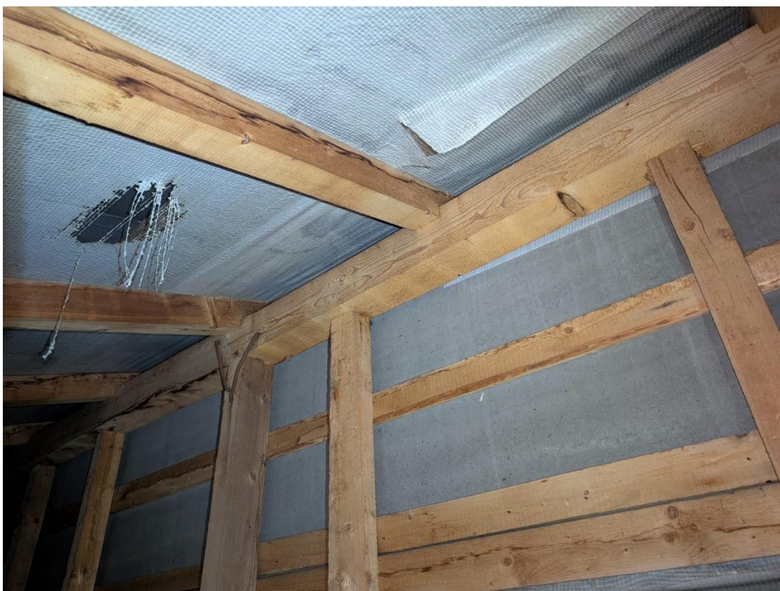
Obrázek 15 Poškozená folie
